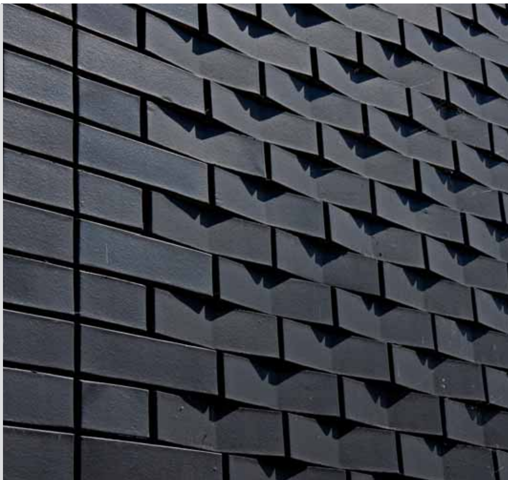
seitliche Ansicht: 205954 Dresden schwarz-blau-bunt glatt NF, Schattenfuge, ohne Mörtelfuge geklebt
